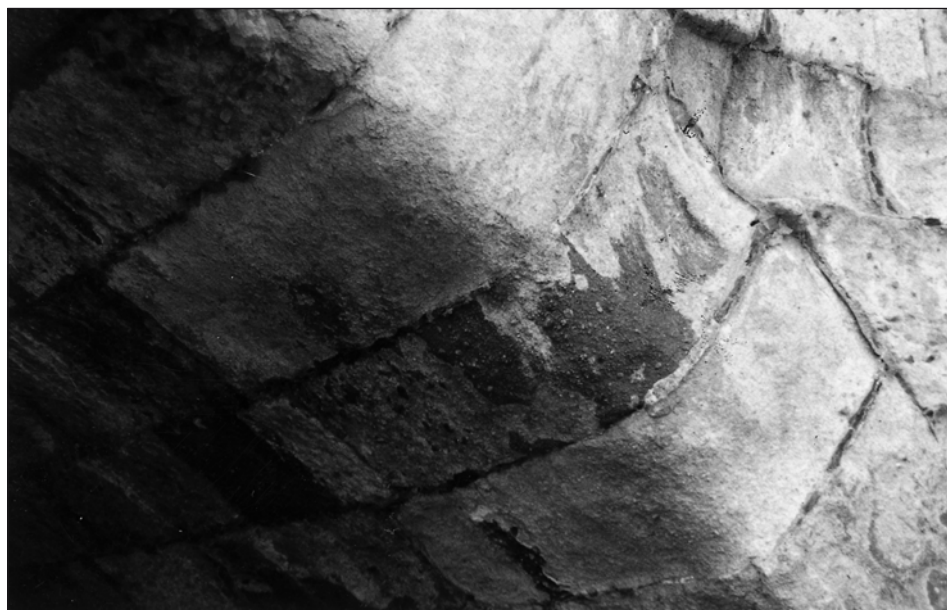
Fig. 10.—Boquillas de arenisca redondeadas en la parte moderna del puente Mayor de Salamanca.
