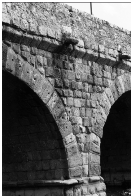
FIG. 5.–Hilada cortada por el medio bajo la cornisa superior en el puente Mayor de Salamanca.
