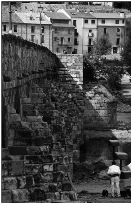
FIG. 15.— Ondulación de la imposta que corre sobre los arcos del tramo moderno del puente Mayor de Salamanca.
