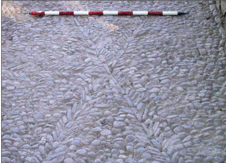
FIGURA 13.— Cruceta del pavimento que cubre a la estancia perimetral del claustro. s. XVII.
